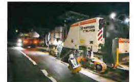
舗装工事イメージ
